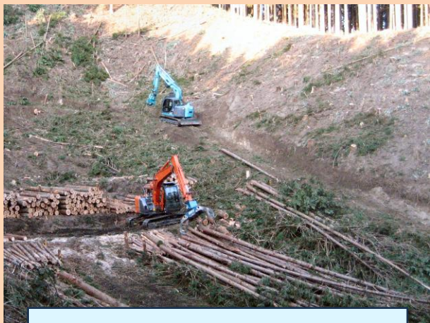
高性能林業機械を導入した皆伐作業
