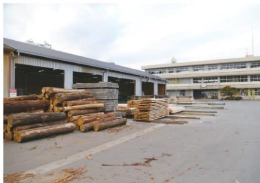
集成材の原料を製造する工場
