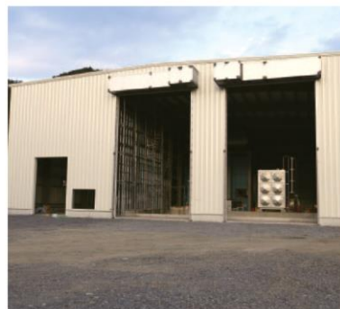
住友金属鉱山シボレックスへの熱供給施設(建設中)
